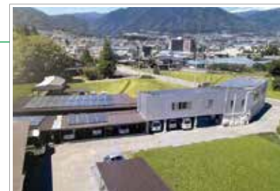
車庫の屋根のソーラーパネル
